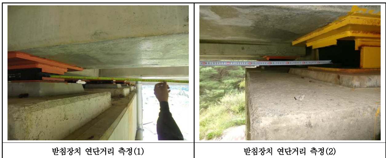
【사진 16.3.39】 교량받침장치 연단거리측정
