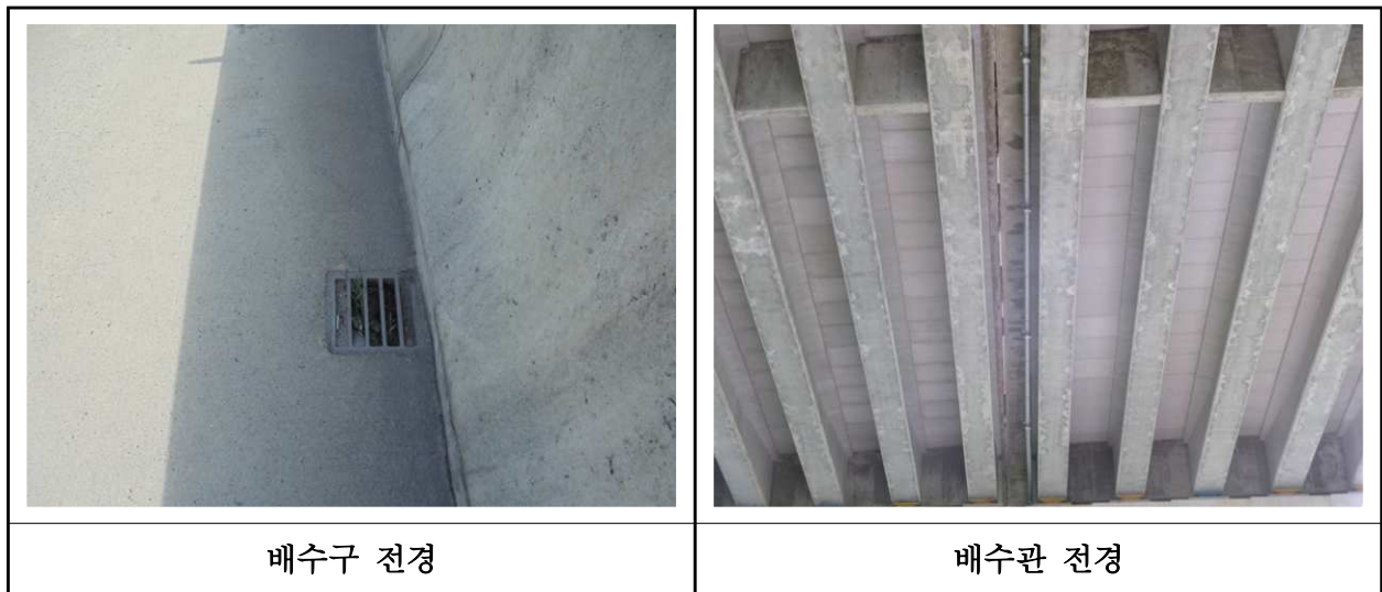
【사진 16.3.46】 배수시설 전경
