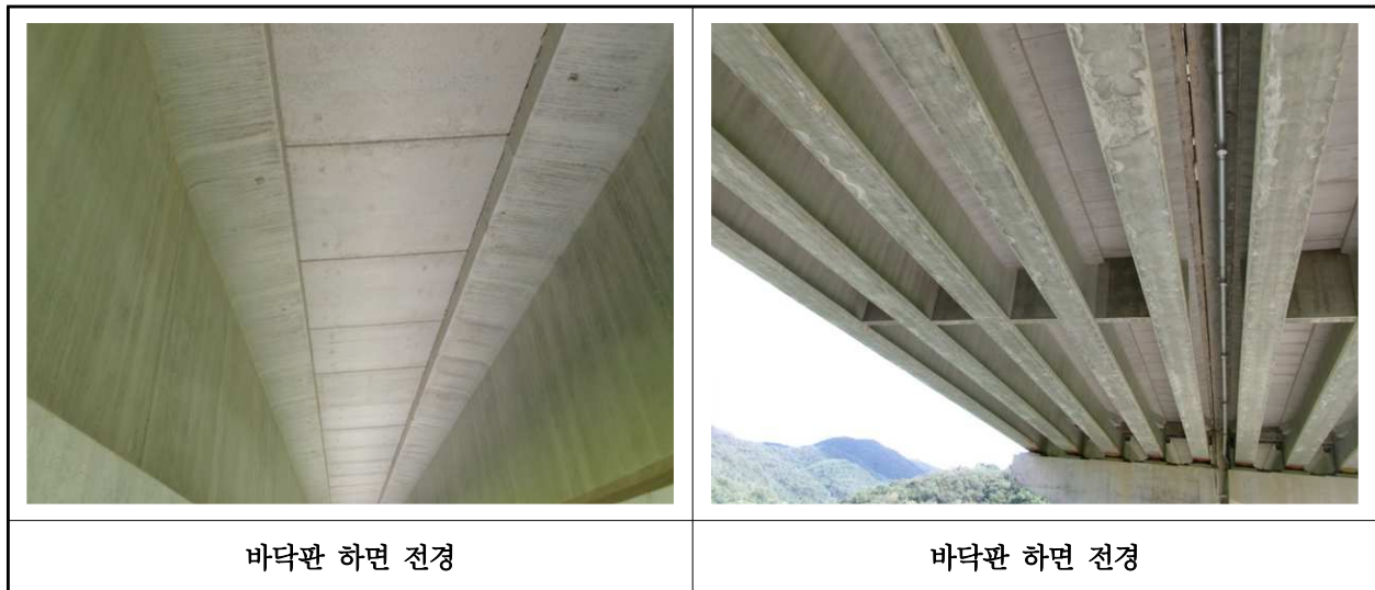
【사진 16.3.2】 바닥판하면 전경
