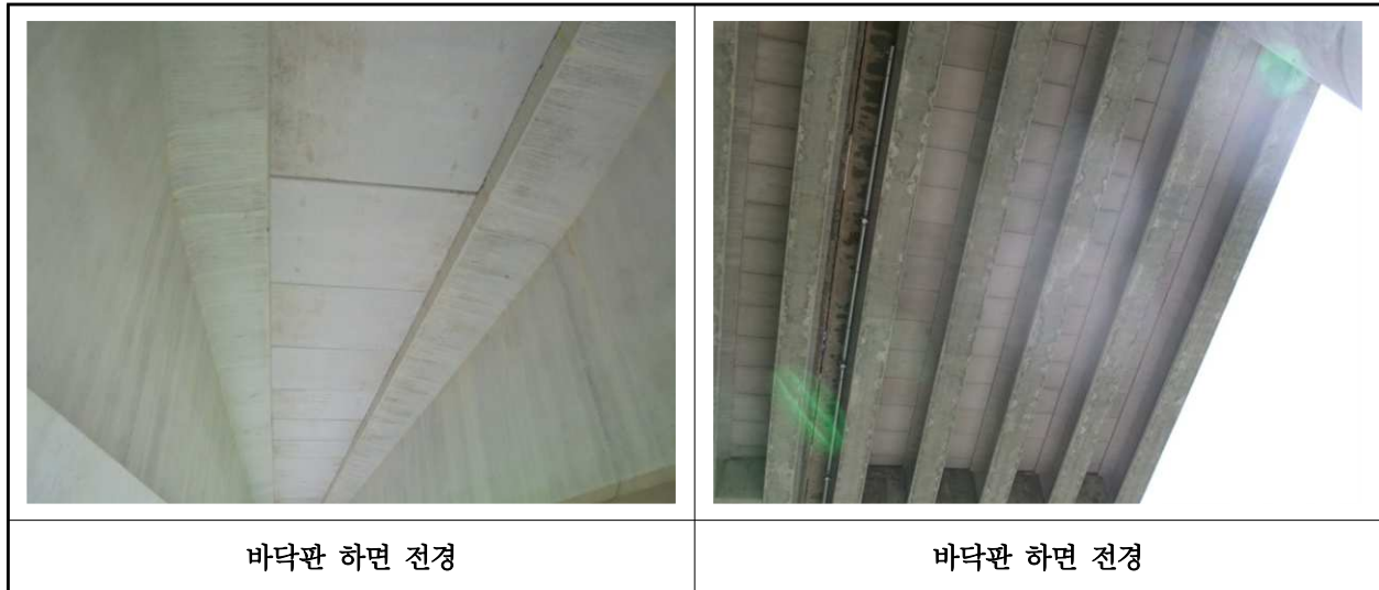
【사진 16.3.27】 바닥판하면 전경
