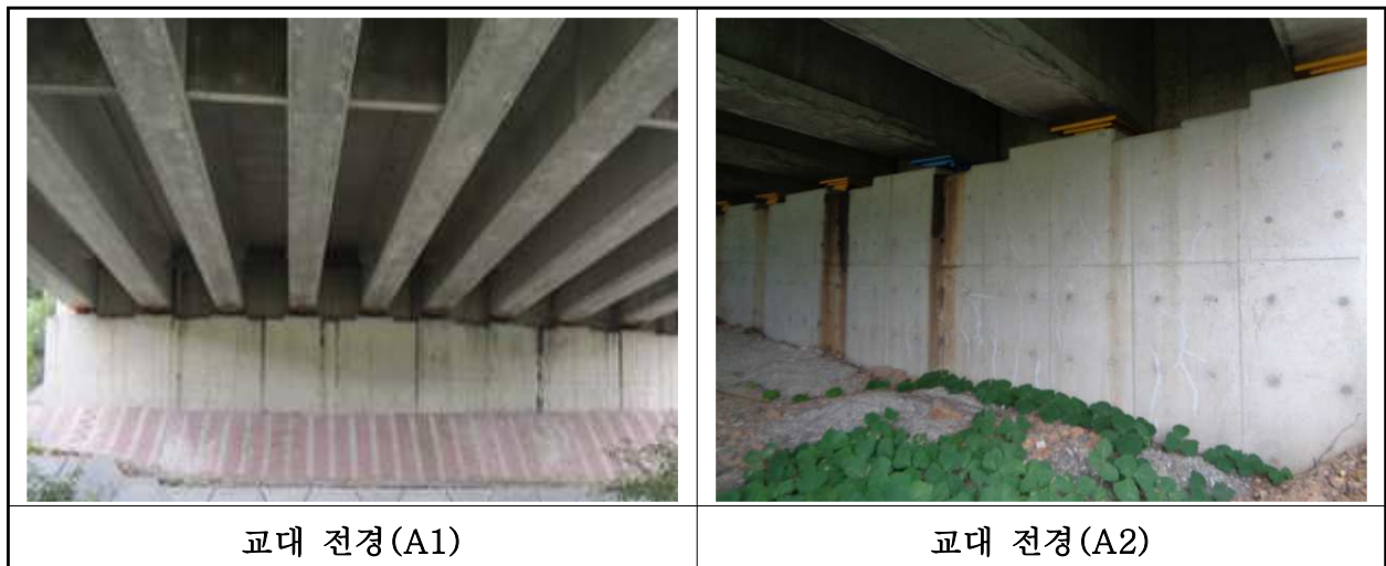
【사진 16.3.33】 교대 전경
