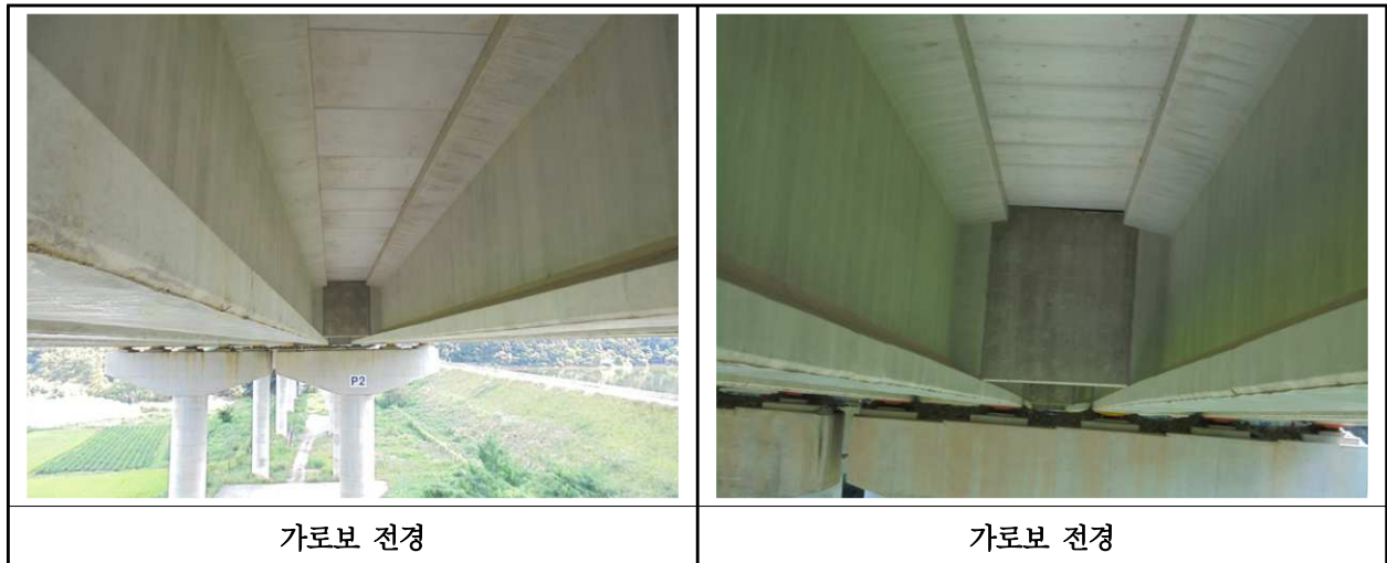
【사진 16.3.31】 가로보 전경
