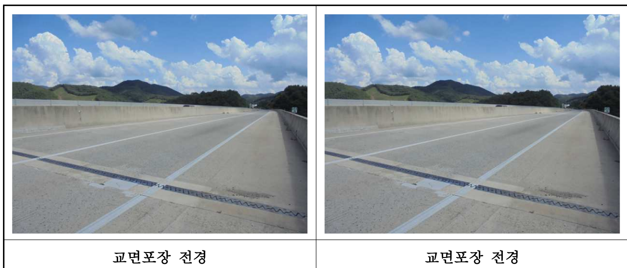
【사진 16.3.44】 교면포장 전경
