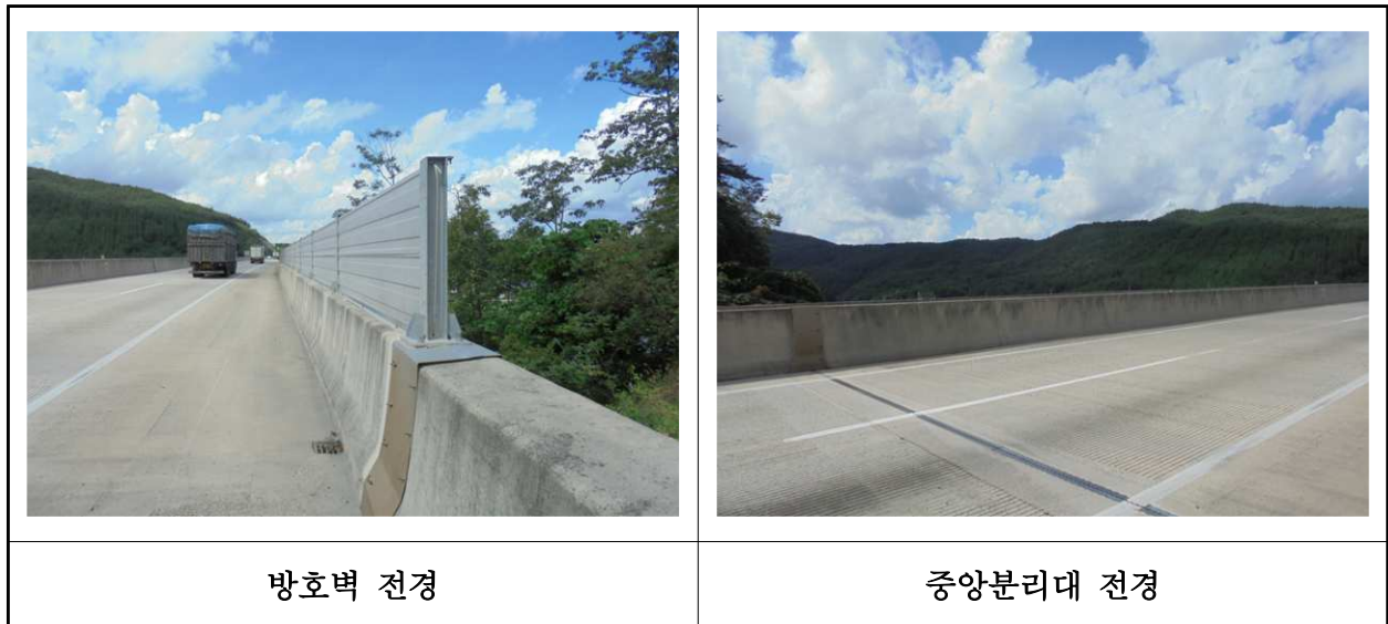
【사진 16.3.23】 방호벽 및 중앙분리대 전경
