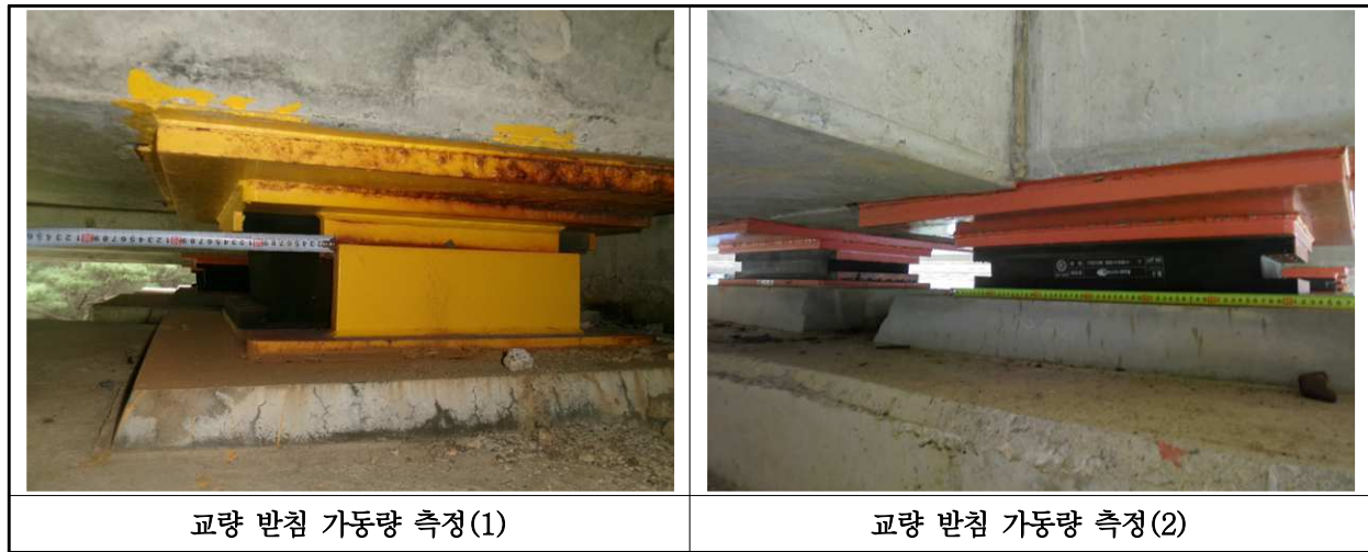
【사진 16.3.40】 교량받침 이동량 측정
