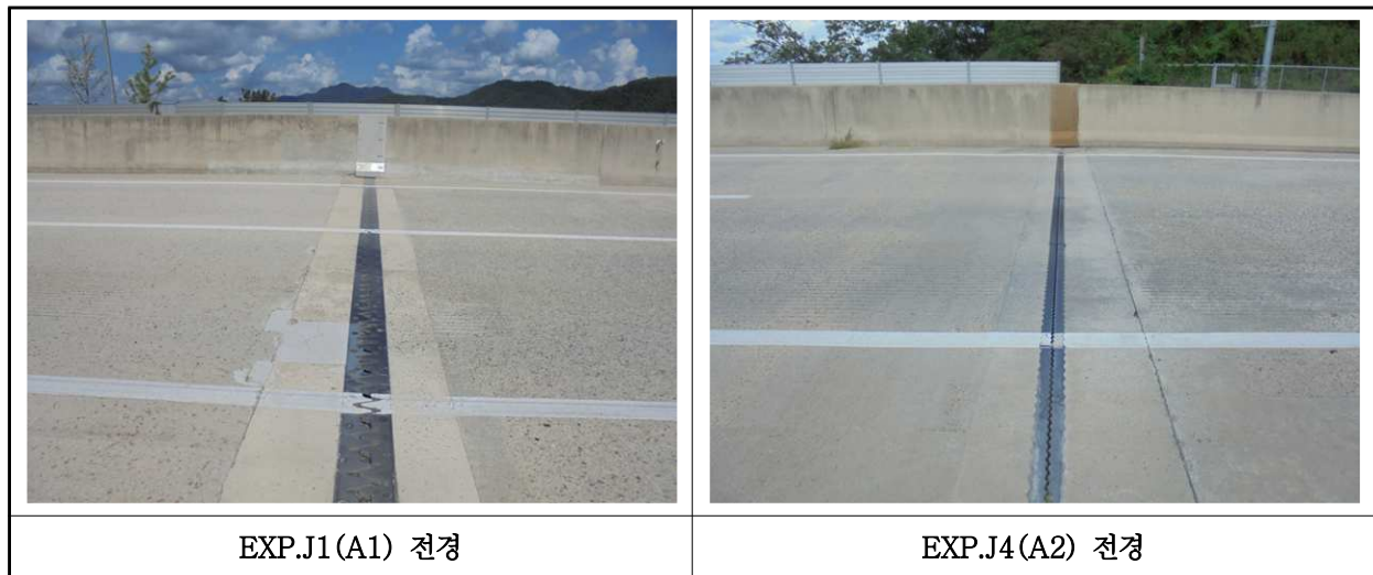
【사진 16.3.41】 신축이음장치 전경
