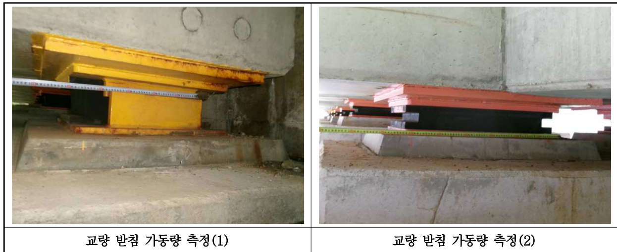
【사진 16.3.15】 교량받침 이동량 측정
