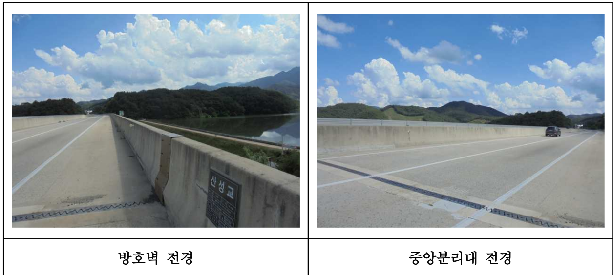
【사진 16.3.48】 방호벽 및 중앙분리대 전경
