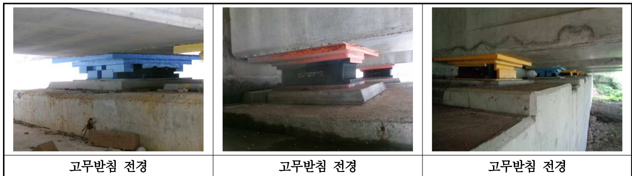
【사진 16.3.12】 교량반침 전경
