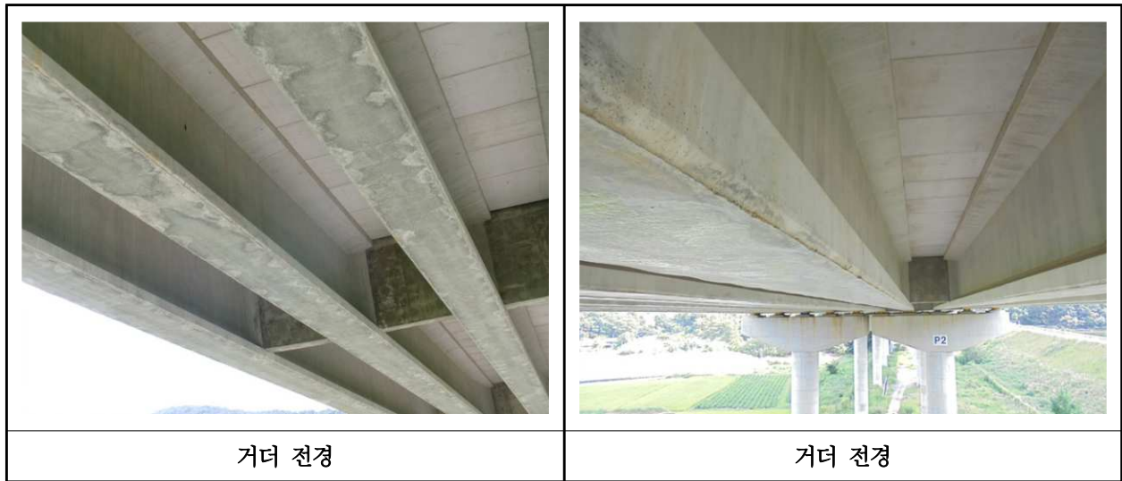
【사진 16.3.29】 거더 전경
