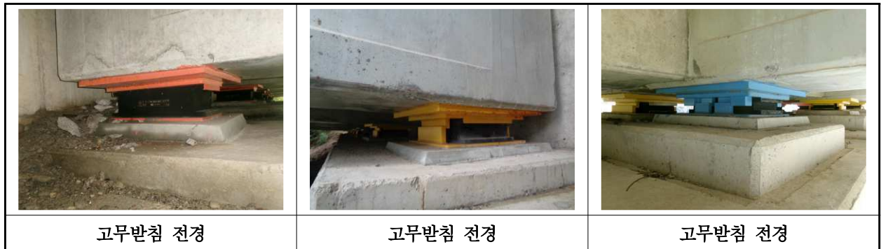
【사진 16.3.37】 교량반침 전경
