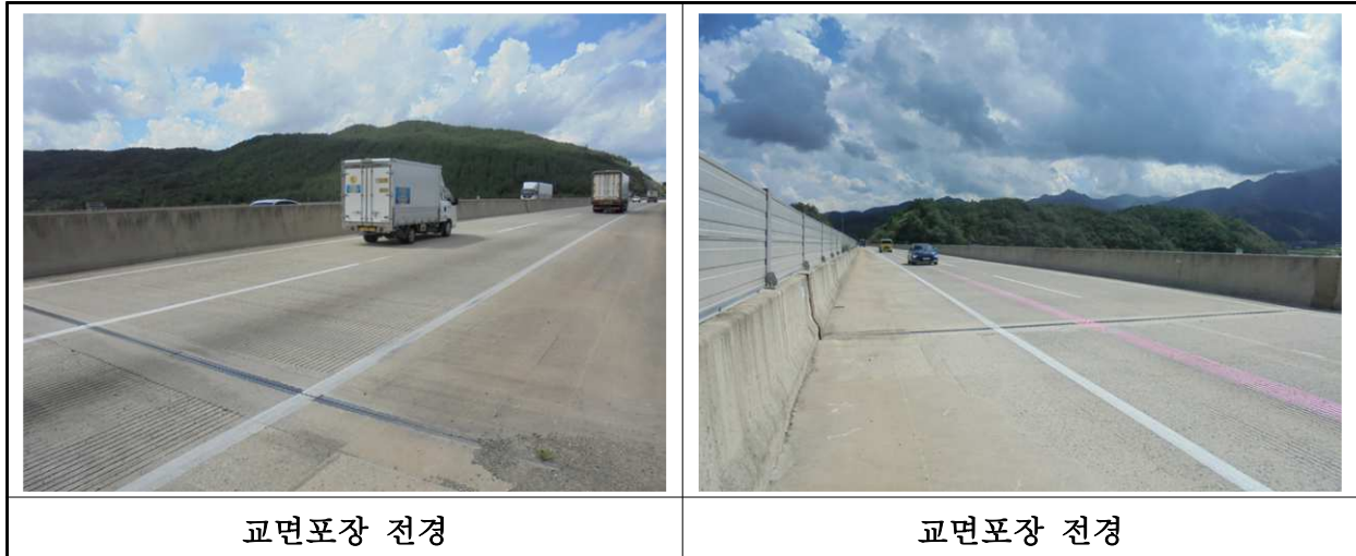
【사진 16.3.19】 교면포장 전경
